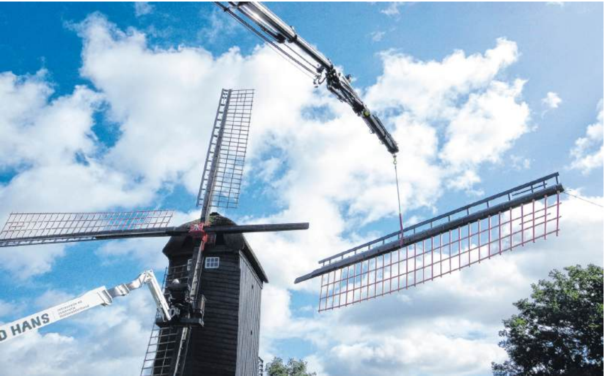
De rechter wiek wordt aan de molen bevestigd.
