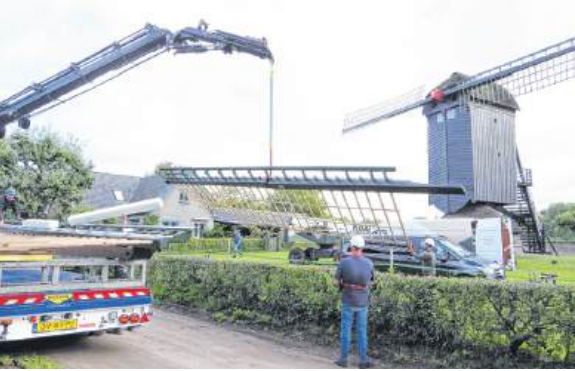
De rechter wiek wordt van de wagen getilt.
