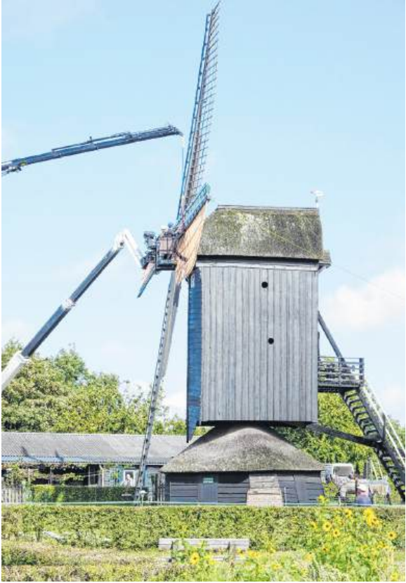
De rechter wiek wordt bevestigd.
