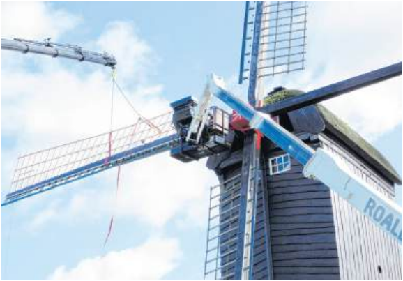
Monteurs zijn bezig de wiek aan de roede te bevestigen.
