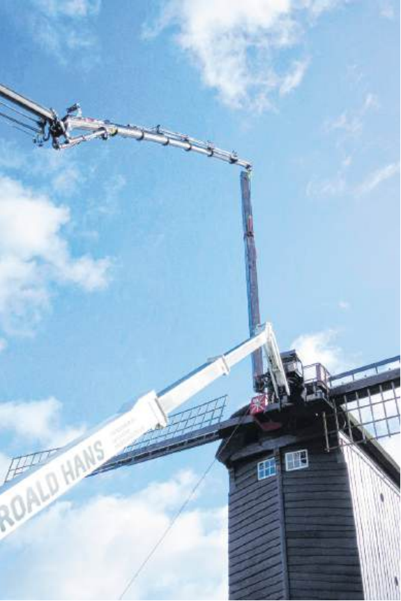
De wiekroede wordt in de wiekas gehangen.
