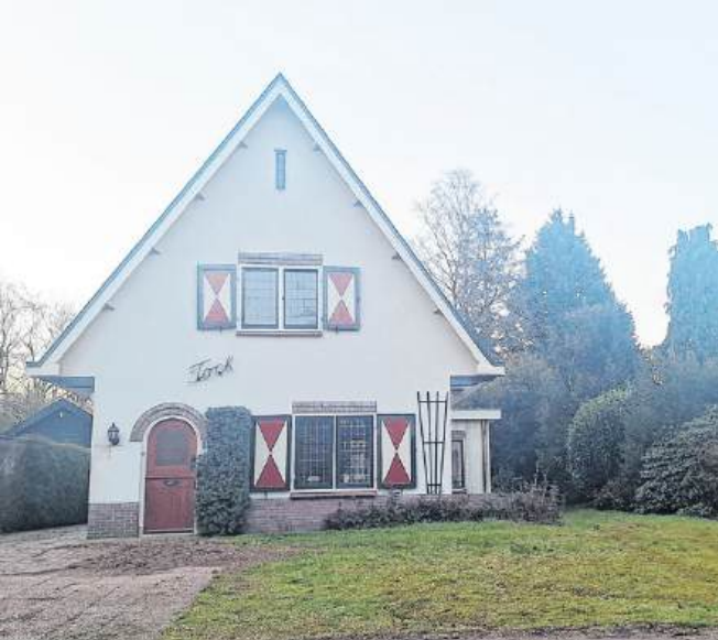
Het pand Boslaan 25 voor de verbouwing.
