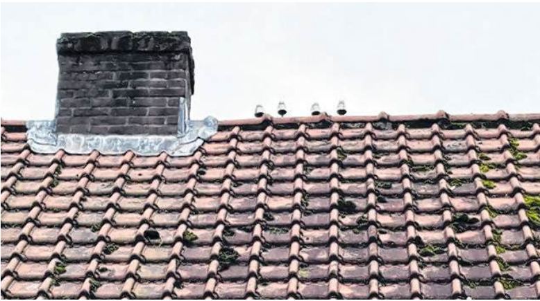
De vier porseleinen isolatoren gaan niet verloren.
