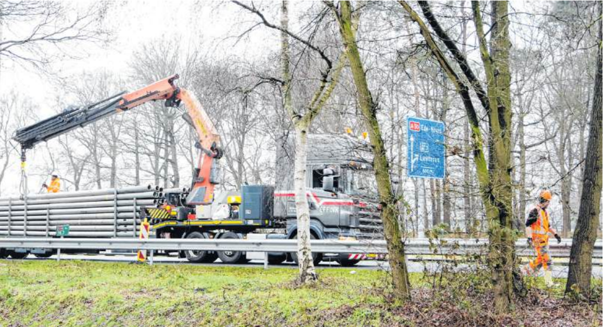
De voorbereidende werkzaamheden van start gegaan, zaterdagochtend 31 januari.
