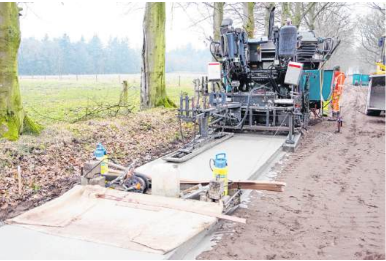
Het nieuwe fietspad in wording.
