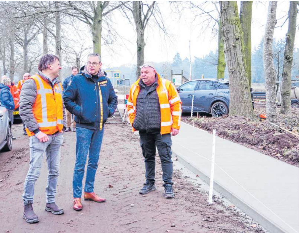
Wethouder Versteeg in gesprek met twee medewerkers van Schagen Infra. Rechts een deel van het vernieuwde fietspad langs de Vijfsprongweg. Merk op, de verhoogde ligging van het fietspad. (foto's: Henk de Rooy)
