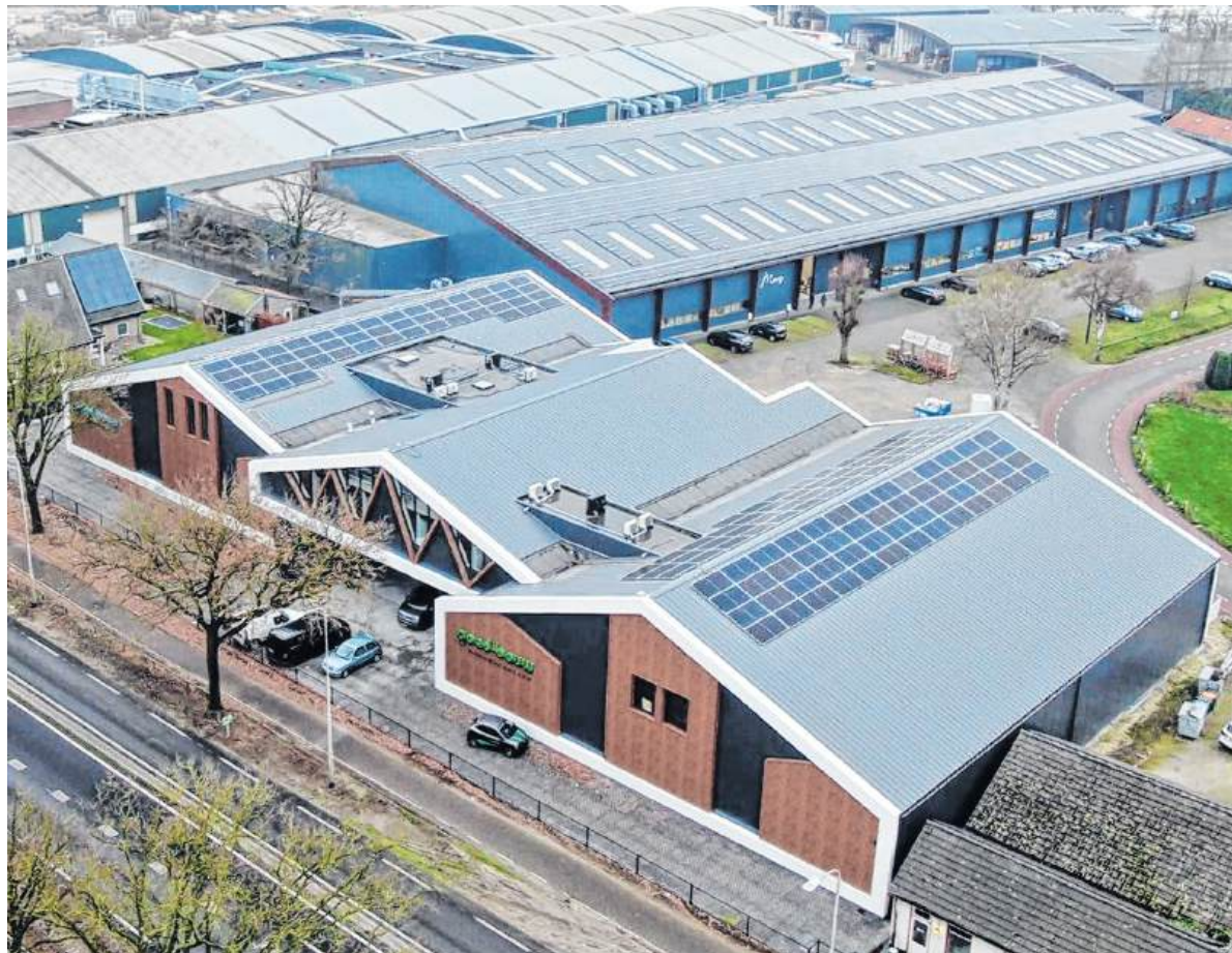
Het pand aan de Kade.
