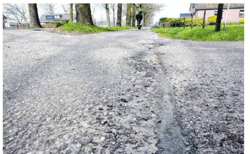
Een naadloze overgang van de ingang van een dam en het fietspad laat op een aantal plekken te wensen over.
