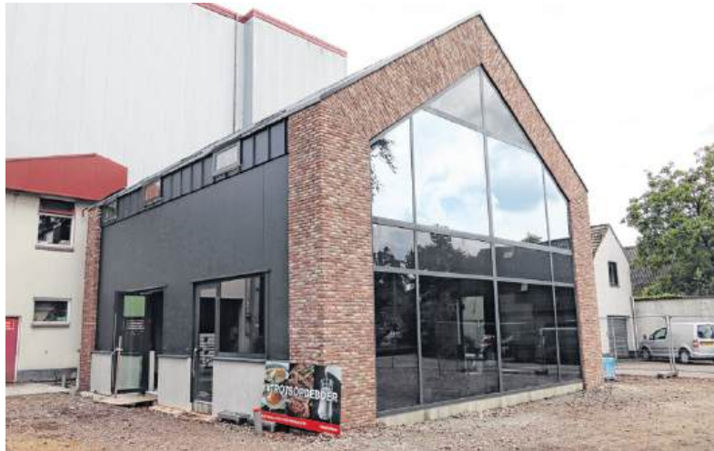
Het nieuwe gebouw voor de operators.
